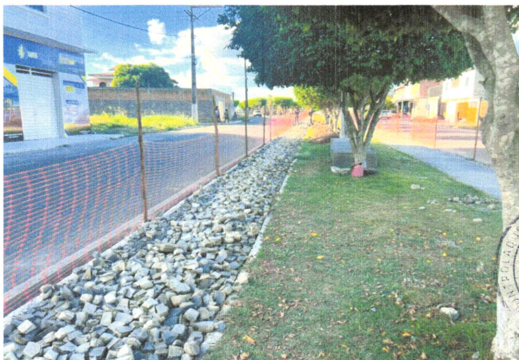
FOTO 08 – REMOÇÃO DE PEDRA PORTUGUESA
